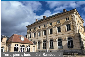
Terre, pierre, bois, métal_Rambouillet
